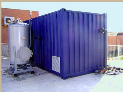
Unidad de descontaminación de suelos y capas freáticas en contenedor
